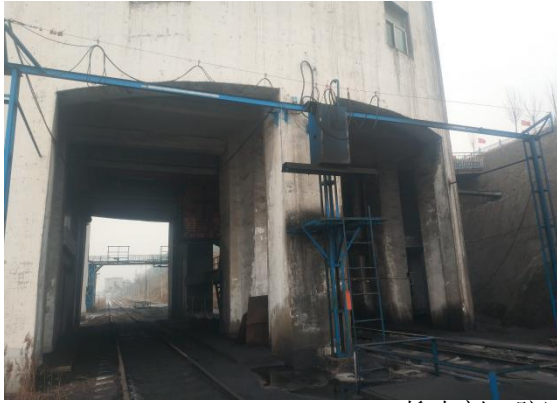
抑尘剂、防冻液喷洒装置
