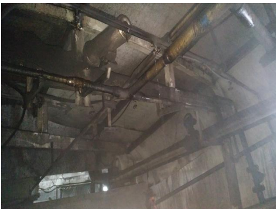
输煤栈桥喷淋设施
